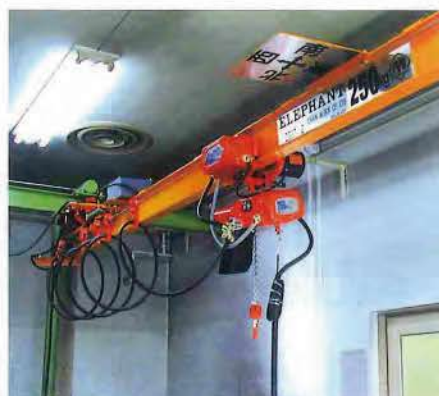
▲天井クレーンミニサドルにセット
